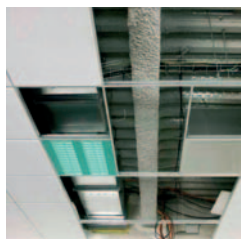
Pose d'un faux-plafond.
